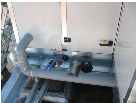
Δίκτυο σωληνώσεων ρnc κυκλοφορία αέρα εντός ΚΚΜ
