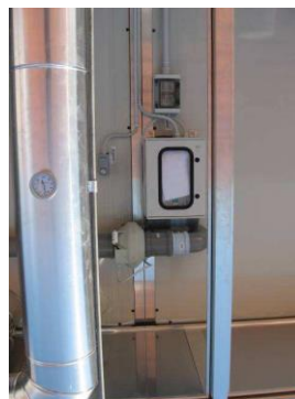
Δίκτυο σωληνώσεων ρnc κυκλοφορία αέρα εντός ΚΚΜ
